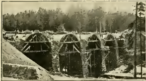
Abb. 131. Viaduct über den Silberhüttenbach, [K. k. Staatsbahn Ober-Cerekwe-Pilgram-Tabor.] [Nach einer photographischen Aufnahme von Ig. Schächtl.]
